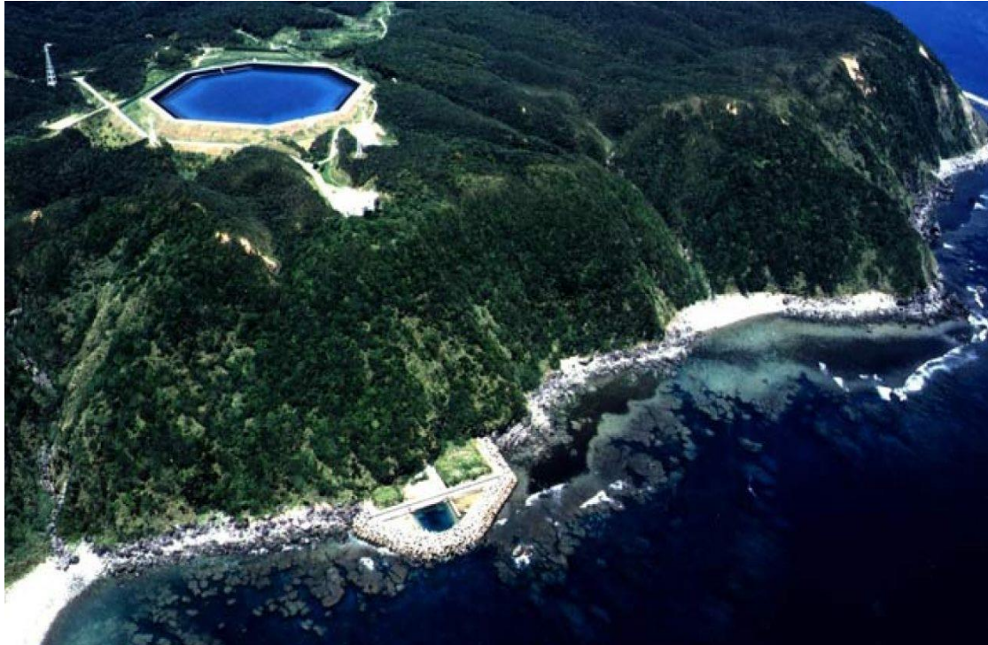
شکل ۲- نیروگاه تلمبه ذخیره‌ای جزیره اوکیناوا، ژاپن (IEA, 2021) 1
