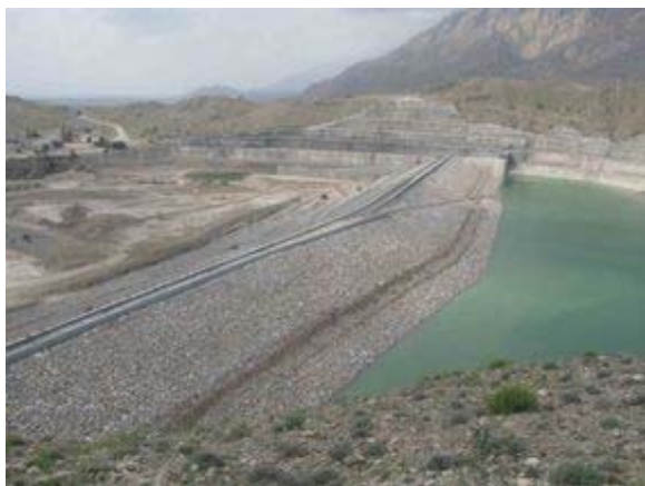
شکل (۲): نمای کلی بدنه سد خاکی شمیل
