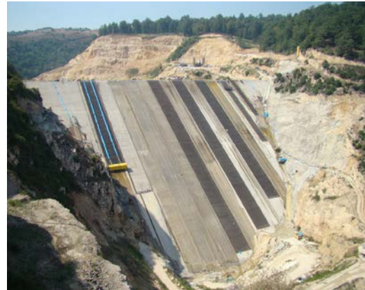
شکل (۱): نمایی از سد در حال ساخت گلورد نکا
