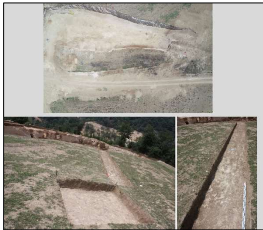
شکل (۲۰): گمانه ۱۰×۱ متر روی عرصه جاده در حال احداث
