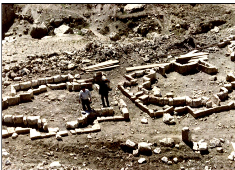
شکل (۸): ردیف‌چینی کلی سنگ‌ها پیش از انتقال به محل جدید (مهر ۱۳۶۶) برای کنترل نهایی با نقشه
