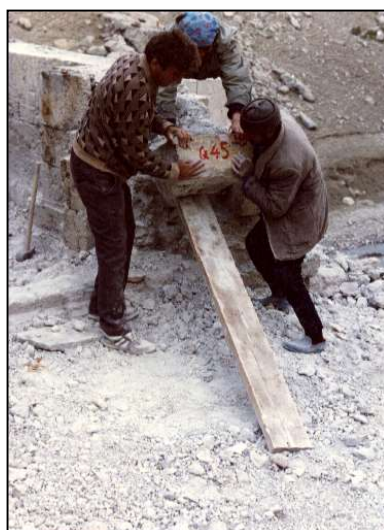
شکل (۷): پیاده‌سازی دقیق سنگ‌ها بر اساس نقشه پس از کدگذاری
