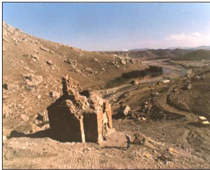
شکل (۱۴): نمای خارجی کلیسا (اضلاع غربی - راست - و شمالی - چپ) پیش از جابه‌جایی. صدمات، ریزش گنبد و تخریب گوشه سازی‌های بام قابل مشاهده است.
