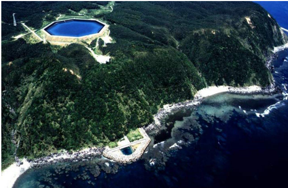
شکل ۲- نیروگاه تلمبه ذخیره‌ای جزیره اوکیناوا، ژاپن (IEA, 2021) 1
