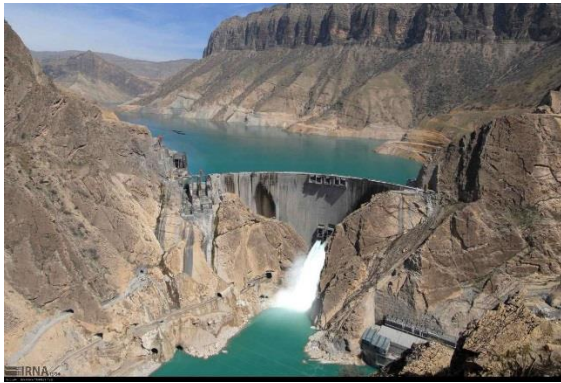
شکل (۲): نمایی از سد و مخزن سد کارون ۴.
