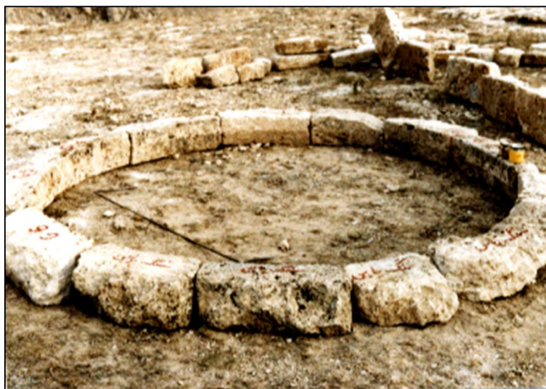
شکل (۹): ردیف‌چینی سنگ‌های طوقه گنبد (مهر ۱۳۶۶) برای کنترل نقشه با وضعیت اصلی بنا
