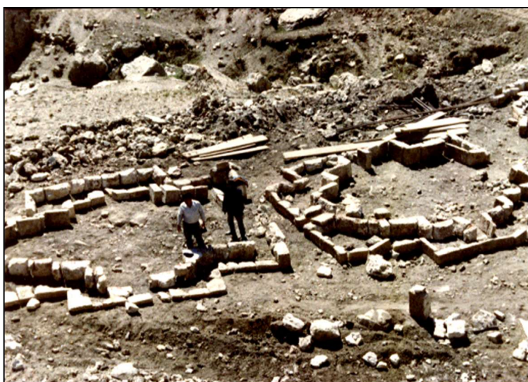
شکل (۸): ردیف‌چینی کلی سنگ‌ها پیش از انتقال به محل جدید (مهر ۱۳۶۶) برای کنترل نهایی با نقشه
