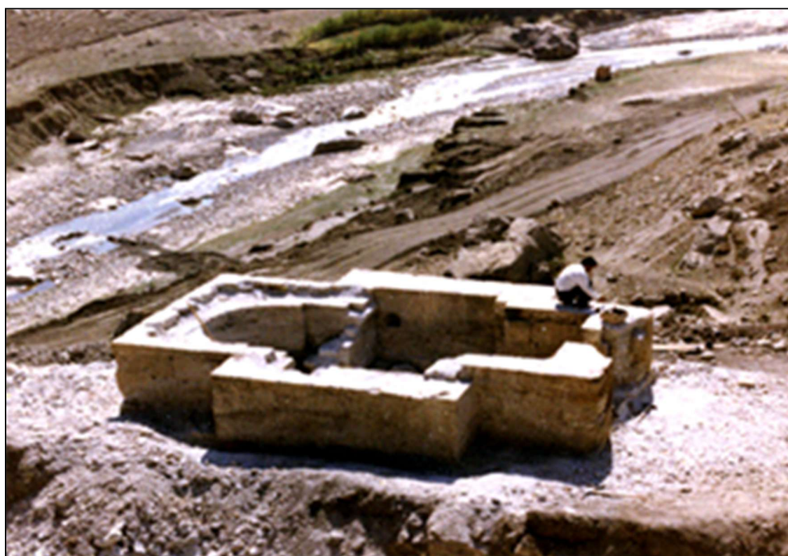
شکل (۵): کدگذاری بر روی لایه های سنگ چینی برای مستند سازی پیش از پیاده سازی
