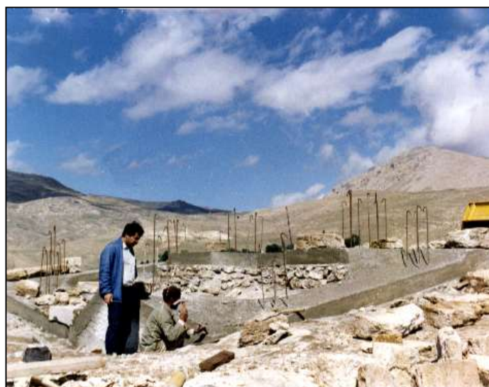
شکل (۱۱): سکو سازی و شیب بندی متناسب با فرم صخره‌ای محل اولیه بنا، همراه با شناژ تقویتی
