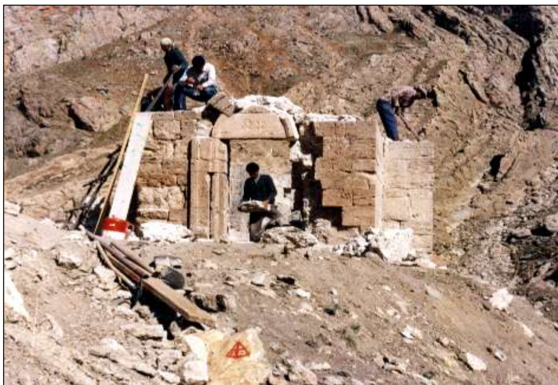
شکل (۴): پیاده سازی سنگ های دیوار غربی و جنوبی تا بالای سر در ورودی
