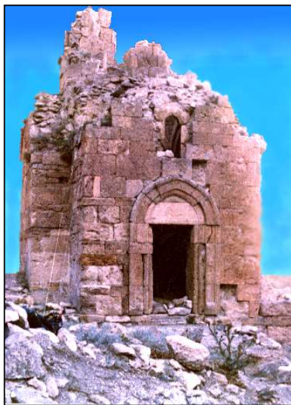
شکل (۱۴): نمای خارجی کلیسا (اضلاع غربی - راست - و شمالی - چپ) پیش از جابه‌جایی. صدمات، ریزش گنبد و تخریب گوشه سازی‌های بام قابل مشاهده است.
